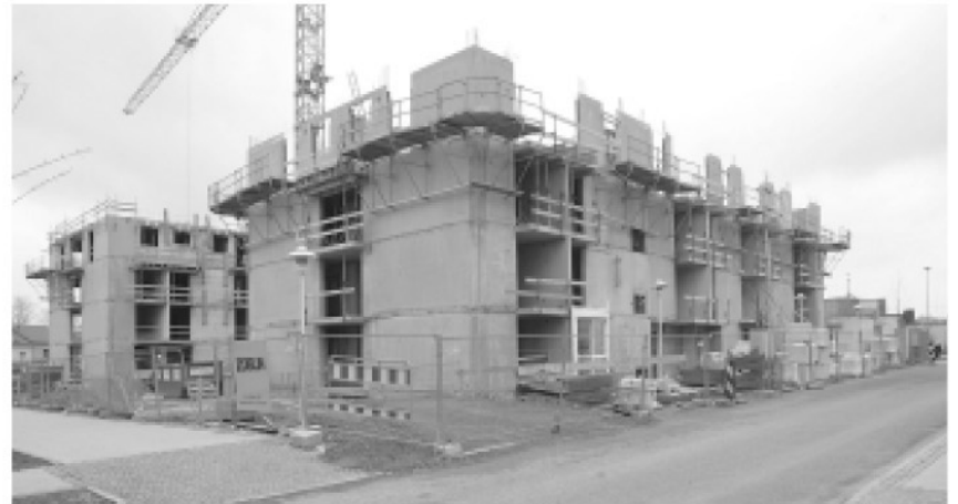
An der Ecke Bahnhofstraße/Käthe-Kollwitz-Straße entsteht die „Residenz am Sommerrain“.
