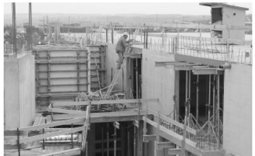
Die Rohbauarbeiten liegen im Zeitplan. Mitte Mai soll Richtfest sein.
